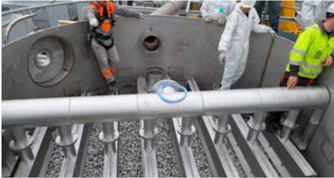
Montaža distributorja kisline v novi AS 1 in zaključnega sloja keramičnih sedel.
