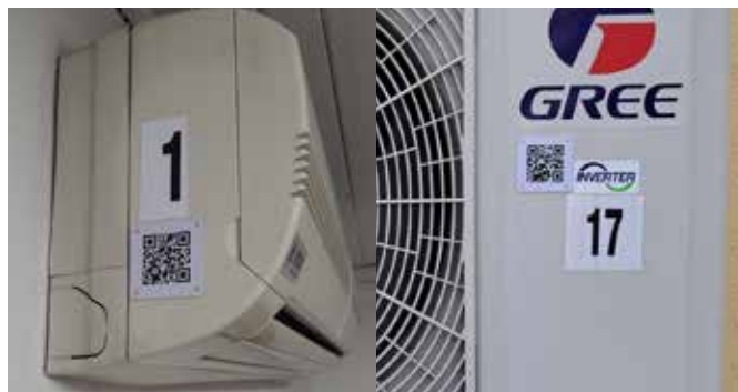
Označena zunanja in notranja enota klimatske naprave.
