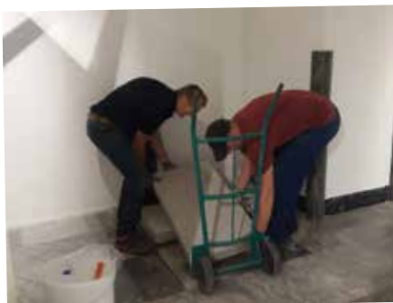
...namestili samočistilne tlakovce pred vhod hiše...
