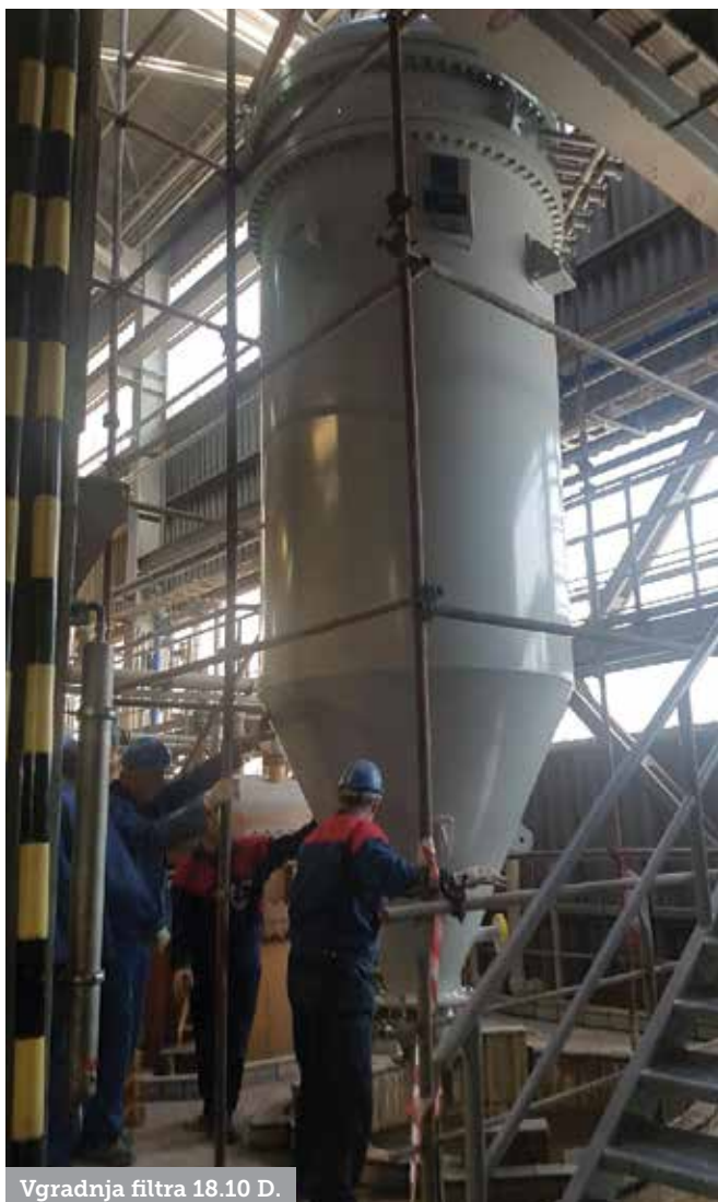
Vgradnja filtra 18.10 D.
