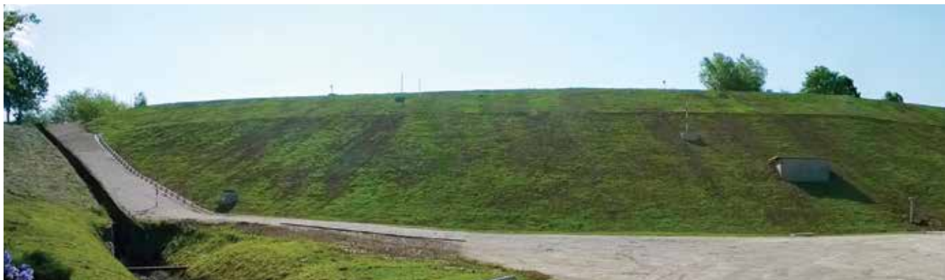
Ojačana pregrada na odlagališču nenevarnih odpadkov Bukovžlak (ONOB)
