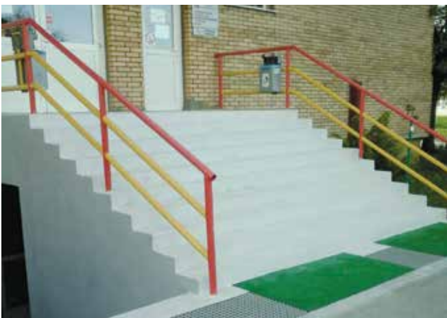
Obnovljene stopnice pred Kadrovsko splošno službo
