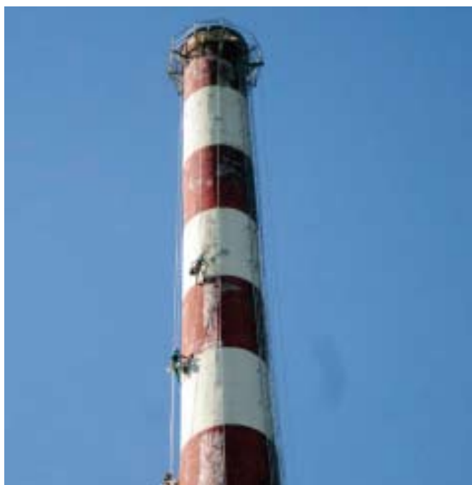
Delavci - alpinisti podjetja EVEREST sanirajo beton
