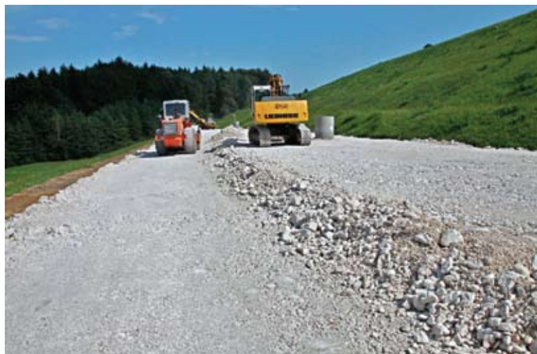
Gradnja nasipa na pregradi Za Travnik
