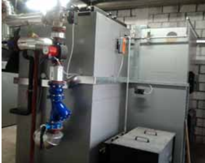
Razdelilnik toplote v kotlovnici
