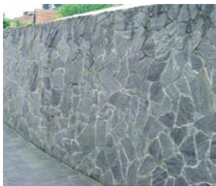
Fasadni podzidek iz skrilavca
