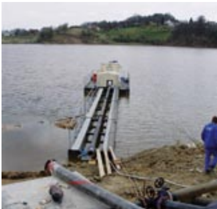
Priključevanje plavajočega cevovoda na prebodu voda - kopno
