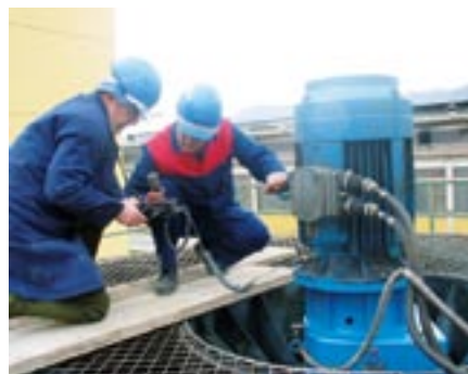
Diagnostiki pri izvajanju meritev
