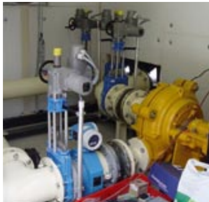
Tandemska črpalka v notranjosti vmesnega črpališča
