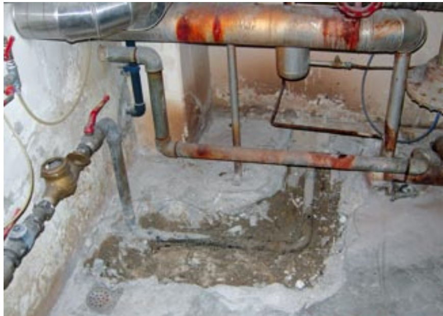
Defekt na pitni vodi v toplotni podpostaji v Grafiki 6.
