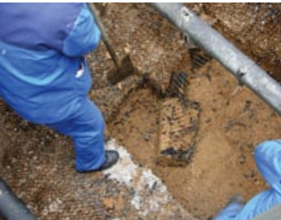
Odstranjevanje polnil v hladilnem stolpu
