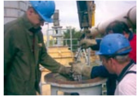
Menjava ležajev mešala v nevtralizaciji
