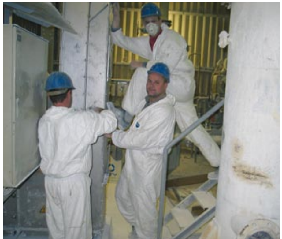
Remont Z elevatorjev
