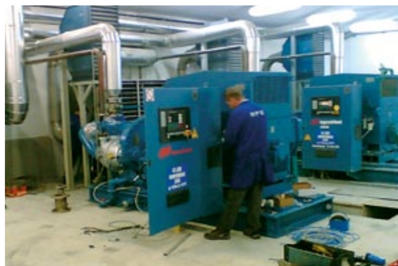
Montaža kompresorja za PD1
