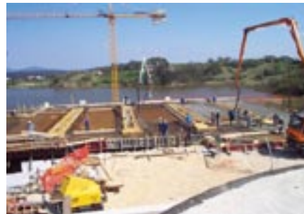
Začetek vliivanja armirane betonske plošče
