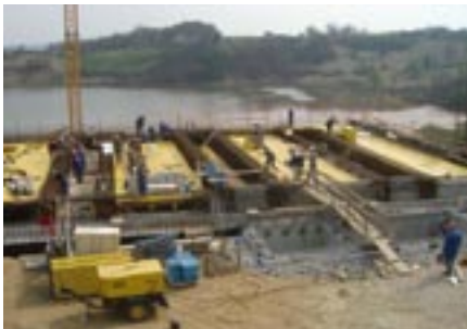
Priprava železne armature ter opaža
