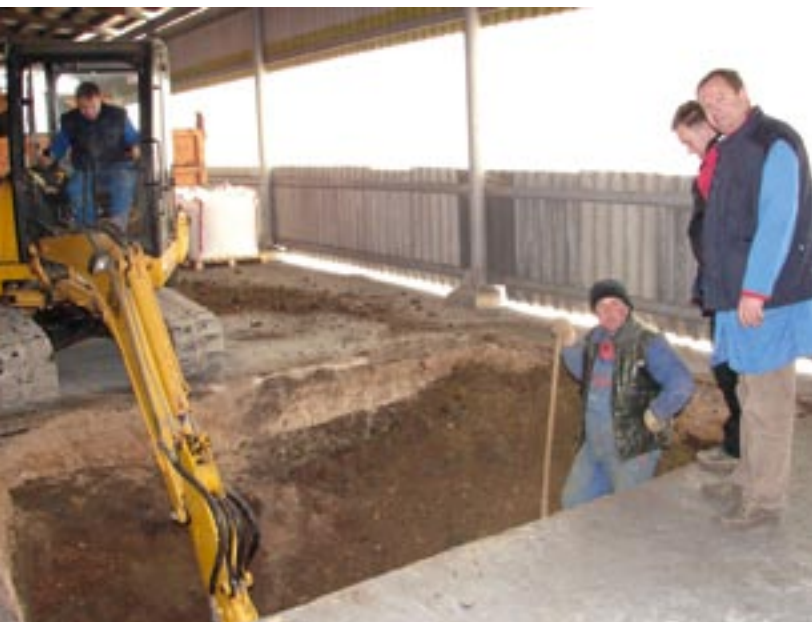
Zamenjava pitnega vodovoda v skladišču PE TiO 2
