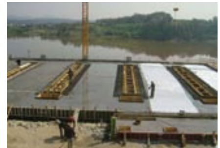
Zaključevanja vliivanja armirane betonske plošče.
