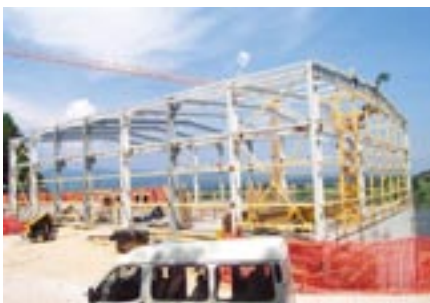
Izgradnja jeklene konstrukcije zgornjega dela
