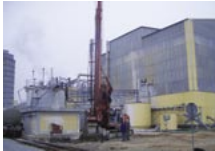
Slika 2: Prvi pilotni temelj proizvodnje CEGIPSA
