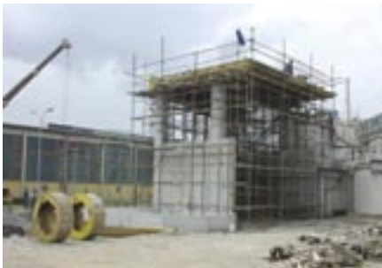
Slika 3: Betonski del objekta, v katerem bosta namščeni centrifugi
