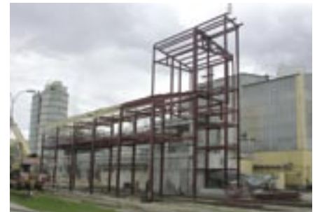
Slika 5: Končna oblika konstrukcije proizvodnje CEGIPSA
