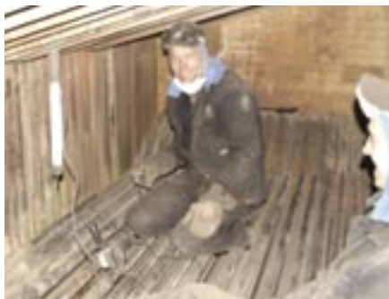
Delavec Dimnikarstva čisti notranjost parnega kotla
