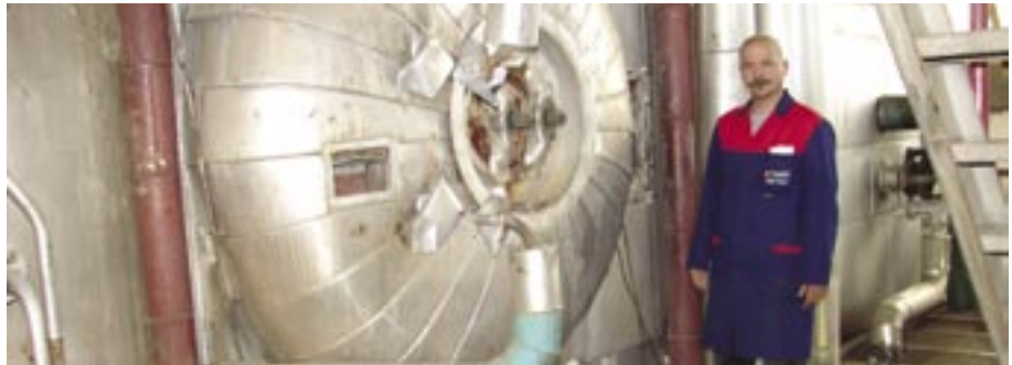
Vodja remonta ob kotlu
