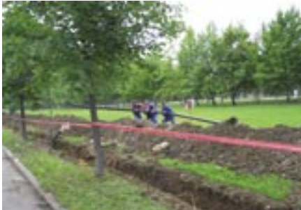
Obnova omrežja pitne vode
