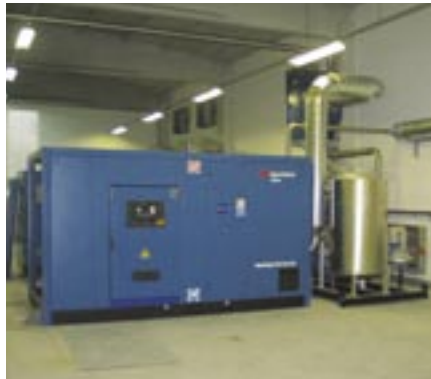
Novi kompresor in adsorpcijski sušilnik
