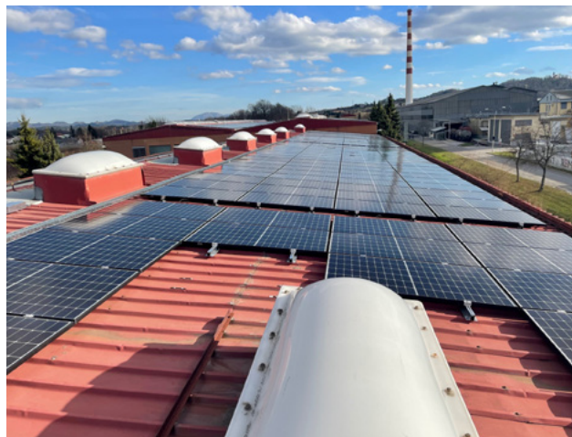
Sončna elektrarna, nameščena na objektih Polimeri. Instalirana moč 492,75 kWp, predvidena proizvodnja 542 MWh.
