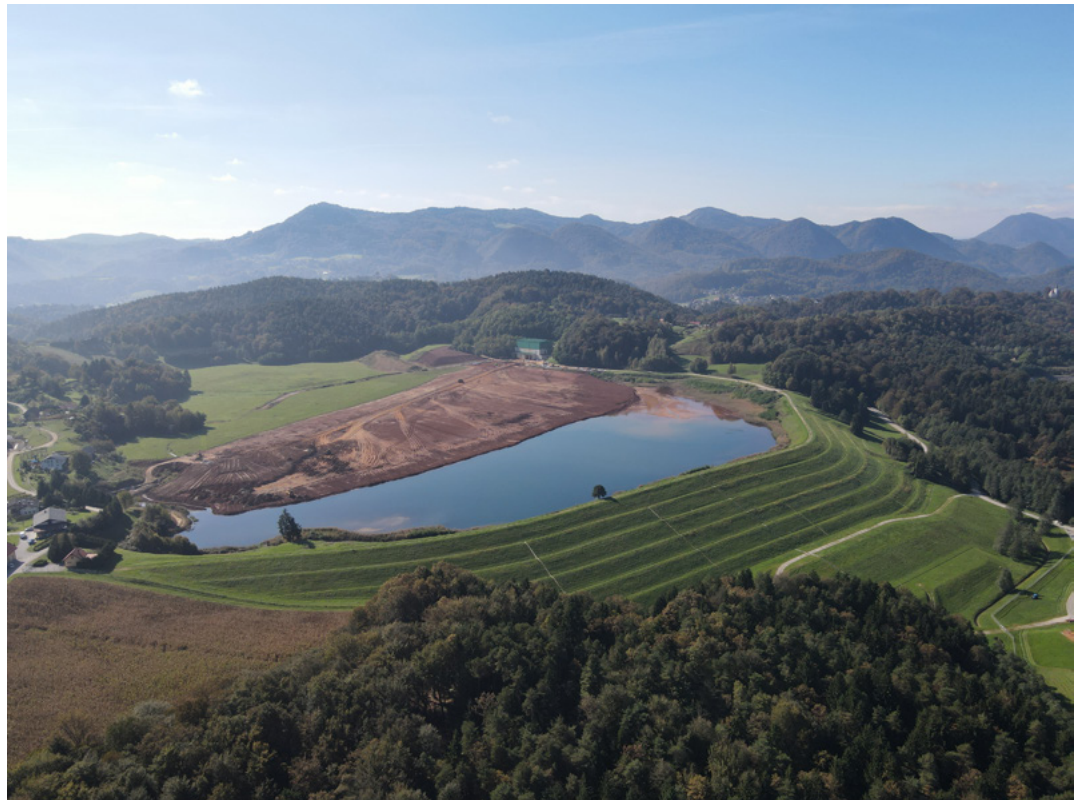
Za Travnikom - naprava za odstranjevanje odpadkov
