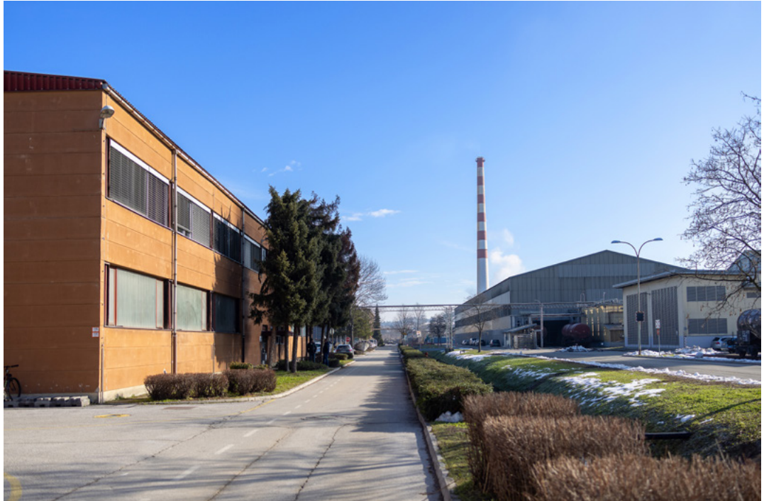
Skozi naše industrijsko območje v Celju je speljan S kanal za odvodnjanje padavinskih in deloma tudi odpadnih voda.
